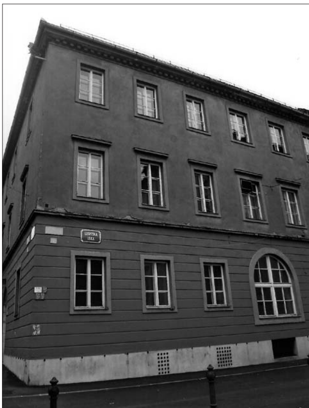
Stavba konservatorija za glasbo in balet na vogalu Turjaške in Gosposke ulice, kjer je bilo poslopje nekdanje policijske direkcije v Ljubljani (foto Pavel Čelik, 2013).
