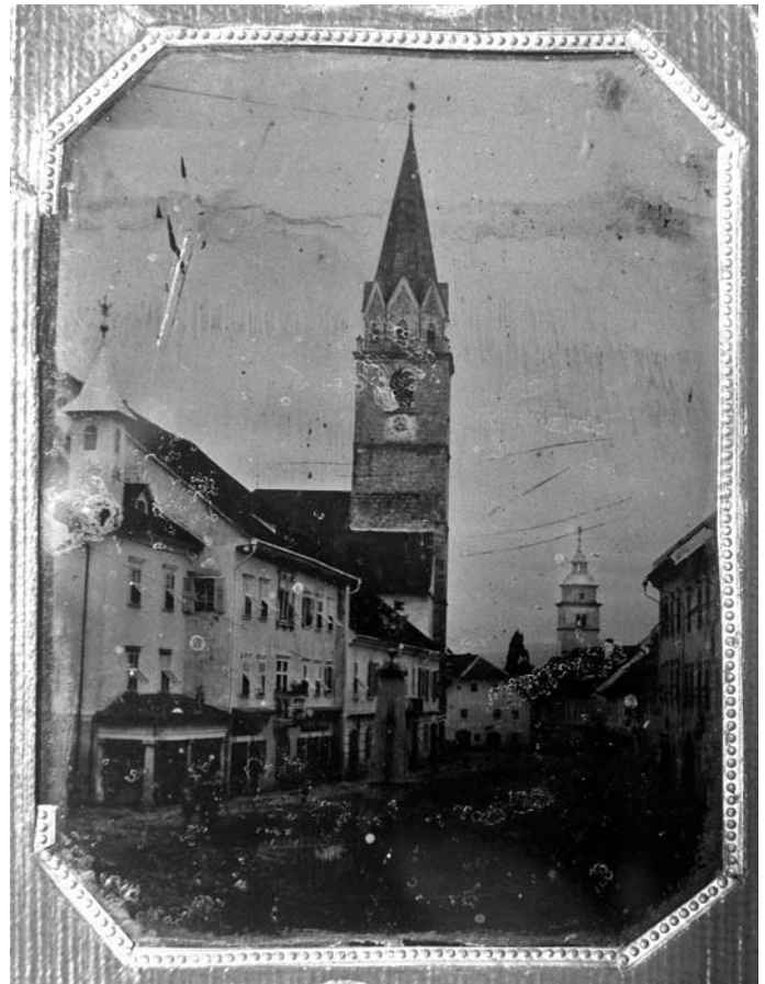
Anonimni avtor: Veduta Kranja; umestitev fotografije na steklu v platnico voščilnice, čelna stran (korekcija nepravilnega formata in robov z usnjeno prevleko); vir: zasebna fototeka B. First.
