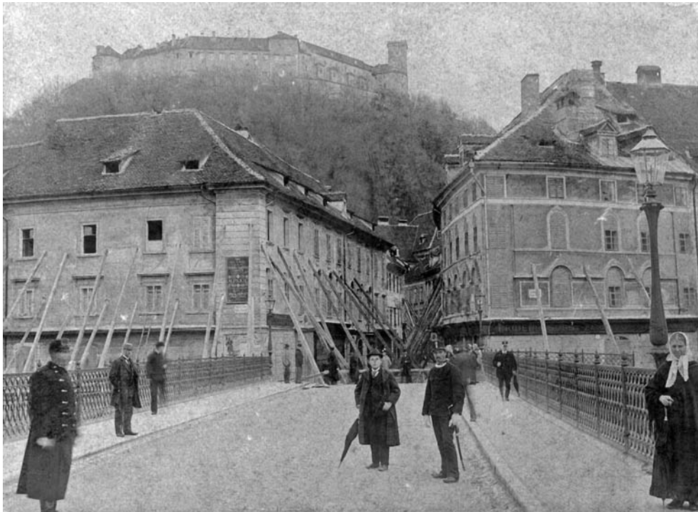
Vhod v nekdanjo ozko Špitalsko ulico (danes Stritarjeva ulica). V ospredju so dobro vidne hiše (levo je stavba nekdanjega meščanskega špitala), ki so bile pred 120. leti v velikonočnem potresu tako močno poškodovane, da so jih morali podreti (SI ZAL LJU 342, Fototeka, A1-060).
