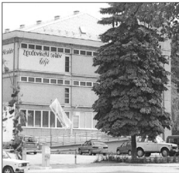
Pogled na nove prostore Zgodovinskega arhiva Celje
