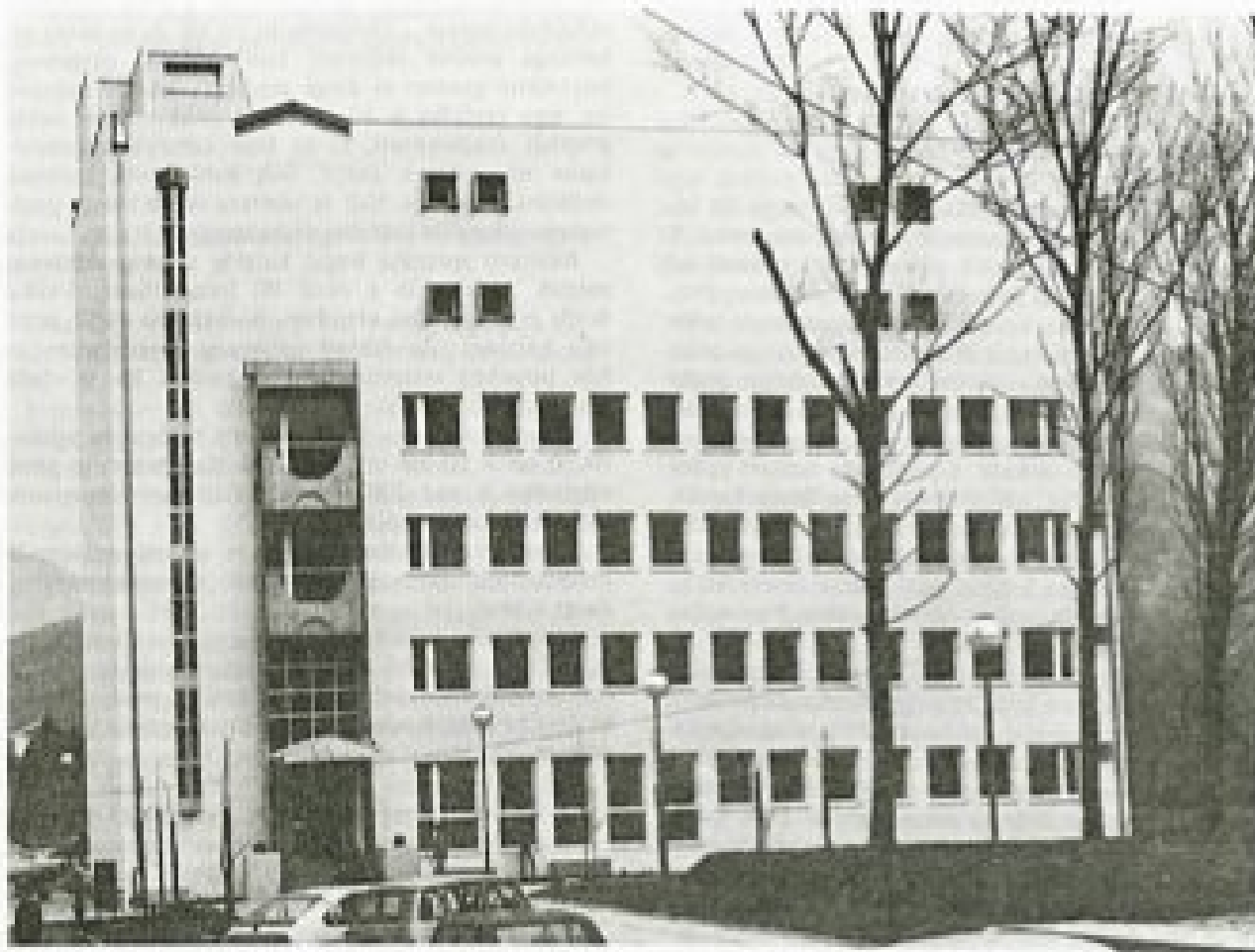
Stavba Pokrajinskega arhiva v Novi Gorici
