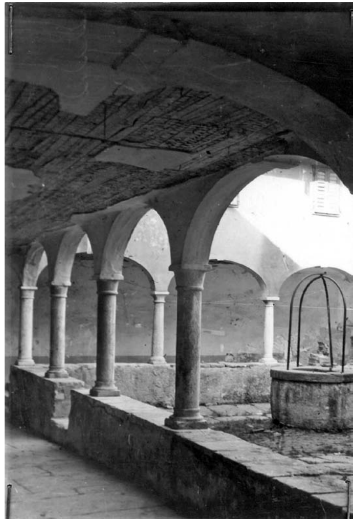
Del križnega hodnika nekdanjega samostana sv. Gregorja (ZVDK Piran, fototeka).
